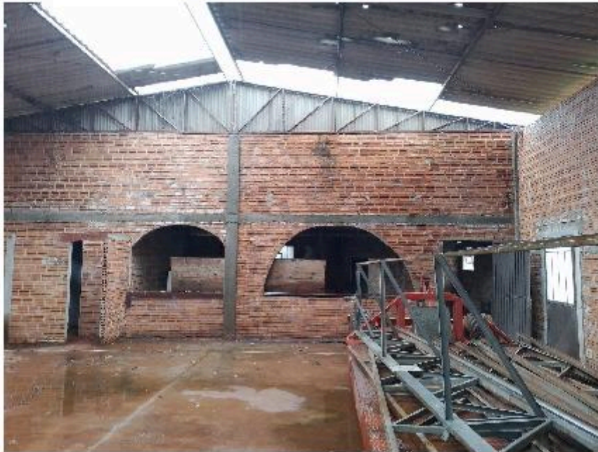
13 Estrutura de Barracão (pré moldado) - para retirar
